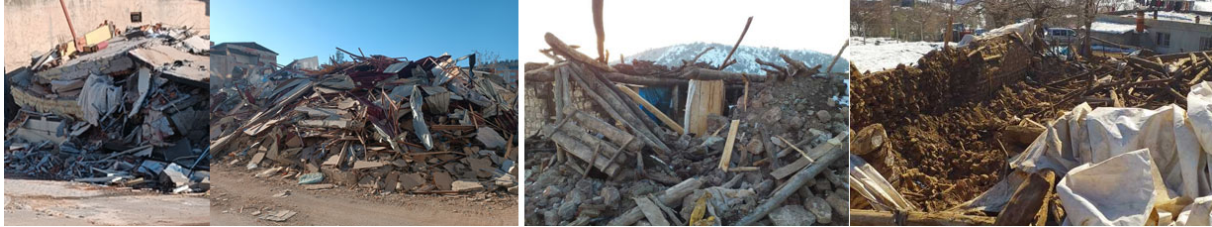
Şekil 3. Toptan göçme oluşan betonarme ve yığma yapı örnekleri
