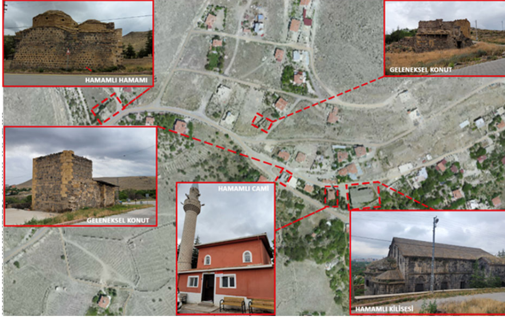
Şekil 7. Hamamlı Mahallesi yapıları
